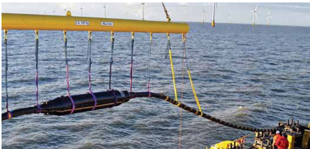
Рис. 6. Подводный кабель с муфтой
