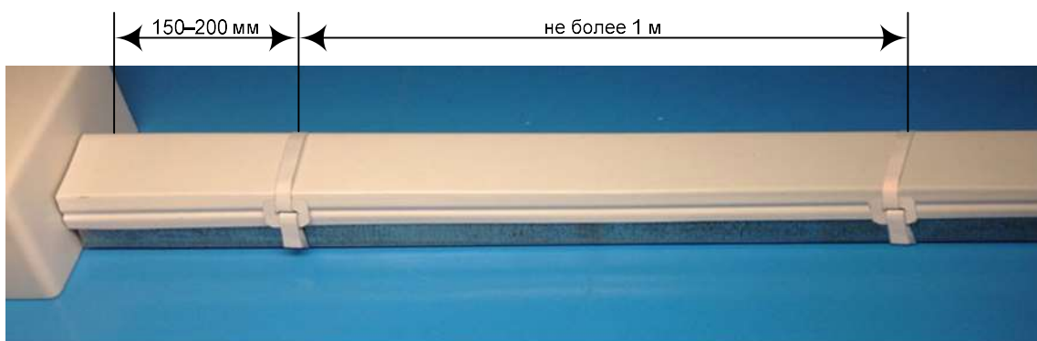
Рисунок 1 - Фиксация верхней крышки
