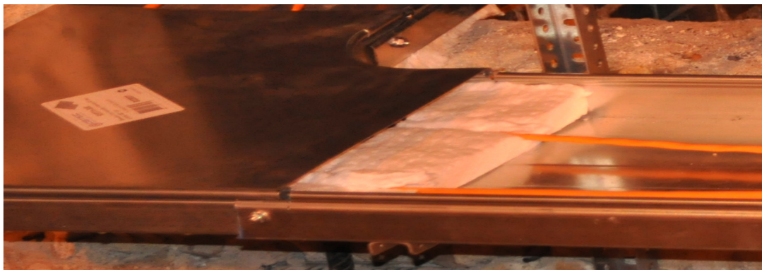
Рисунок 6. Прокладка муллитокремнеземистой ваты.
