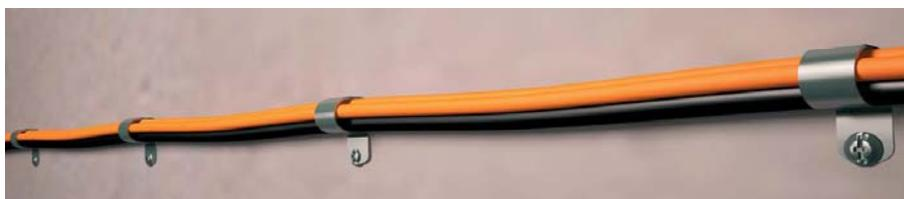
Рис. 11. Пример монтажа ОКЛ СПЕЦКАБЛАЙН-С.
