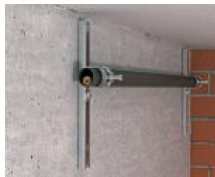
Рисунок А.15 Многорядное крепление трубы к С-образному профилю
