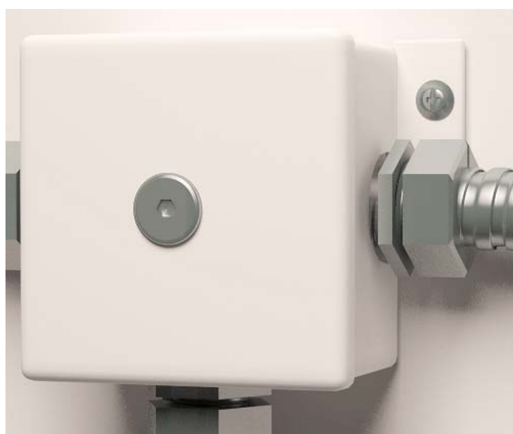
Рис. 8. Пример крепления огнестойкой коробки ДВК.П
