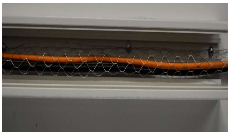
Рис. А.5. Внешний вид СПЕЦКАБЛАЙН-K2Д крепление с помощью самореза с пресс шайбой.
